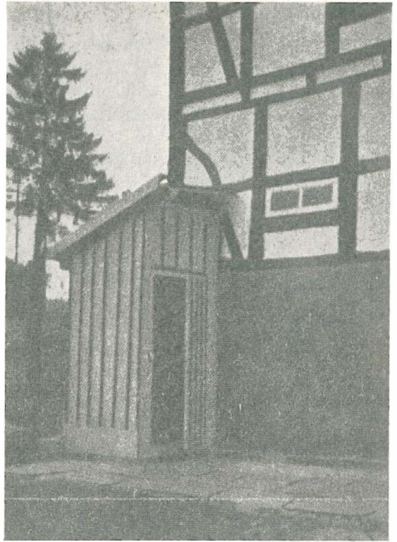
An das Wohnhaus gebaut
