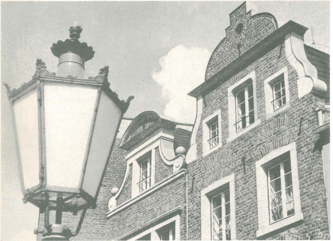
Die neuerrichteten Barockgiebel in der Akademiestraße
