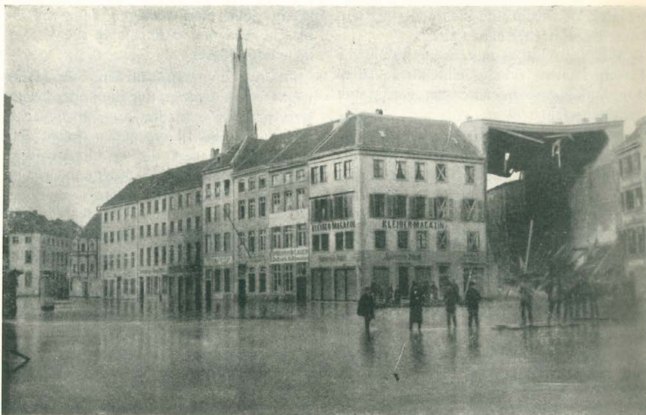
Anno 1882: Der überschwemmte Burgplatz mit dem eingestürzten Haus Sporrer. (Vergl. hierzu die Abhandlung: „Die Rheinüberschwemmung von 1882“ in Heft Nr. 3 „Das Tor“)
