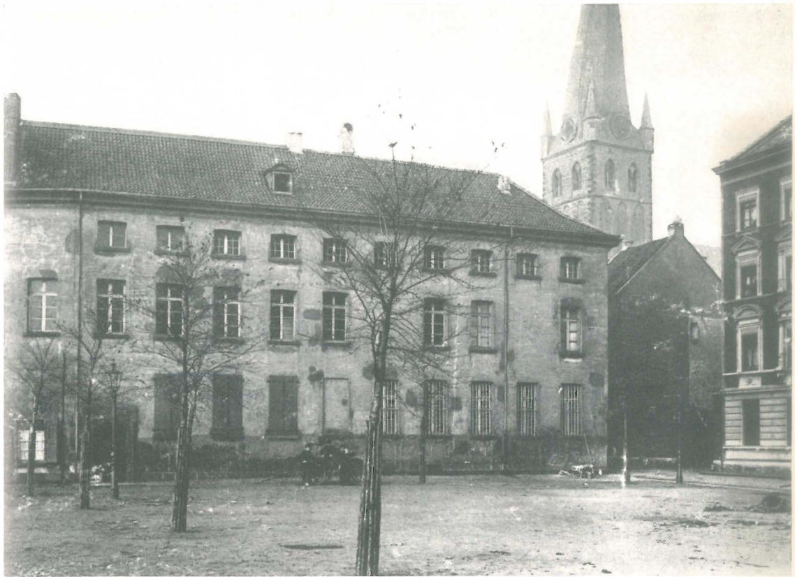
Das Pagenhaus in der Altstadt. Hier befand sich hinter fünf Gittern im Erdgeschoß das erste Geschäftslokal der Sparkasse; rechts die Krämerstraße.
