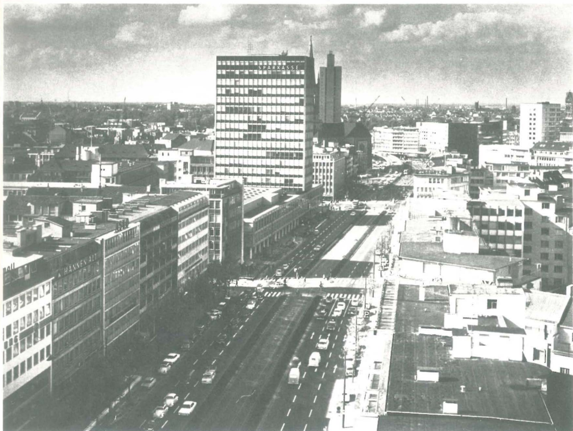
Die Reißbrettstraße Berliner Allee (Foto Gräf)
