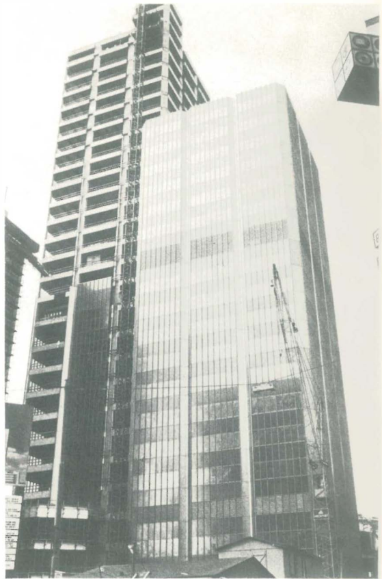
Das neue Hochhaus der Landesversicherungsanstalt der Rheinprovinz, Architekt Prof. Dipl.-Ing. Harald Deilmann
