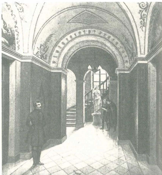
Rudolf Wiegmann: Flur im Wohnhaus Schadows (Schadowstraße, Ecke Bleichstraße)
