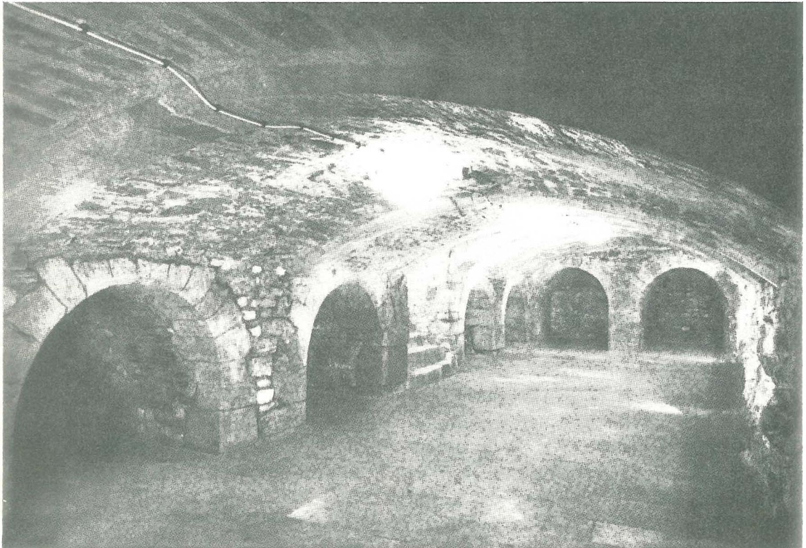
Romanischer Weinkeller in der Südostecke der Basilika
