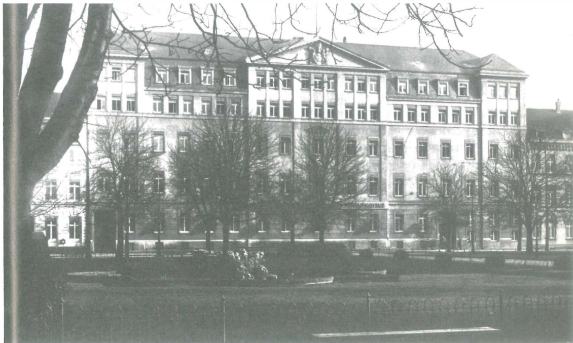
Gebäude der Provinzial-Feuerversicherung nach der Erweiterung von 1921
