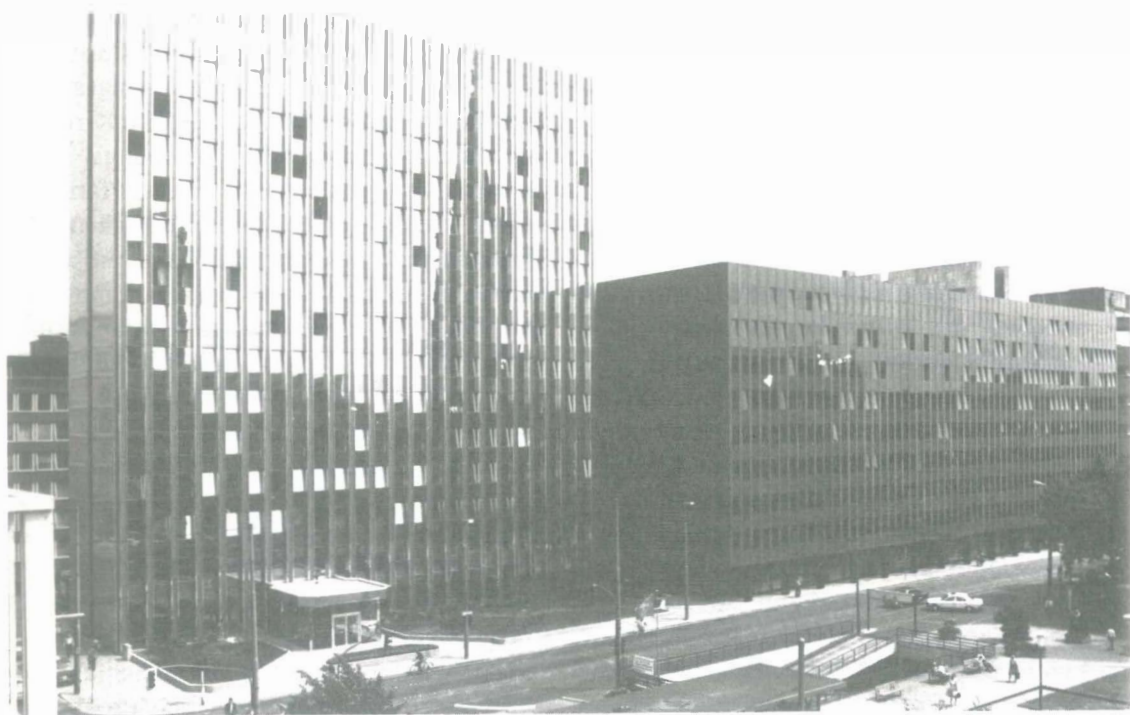
Die Bauten der Provinzial Juni 1978. Links: Hochhaus der Provinzial-Lebensversicherung nach der Sanierung; rechts: Neubau der Provinzial-Feuerversicherung mit einliegendem Pfarrhaus von St. Peter
