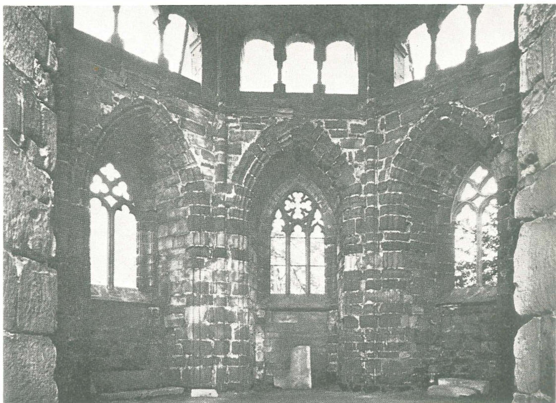
Erdgeschoß des alten Turmes von innen
