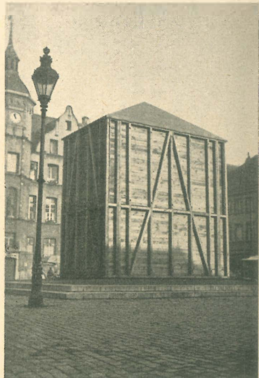
Das „ummantelte“ Jan Wellem-Denkmal, von dem vorher das prachtvolle Eisengitter sinnlos „geopfert“ wurde, auf dem Marktplatz zu Düsseldorf
