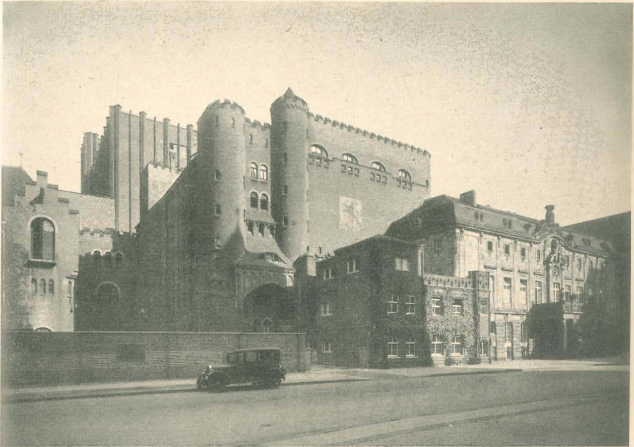
Das Düsseldorfer Schauspielhaus. Blick von der Kasernenstraße auf das Bühnenhaus (Es wurde in einer Bombennacht 1943 zerstört)
