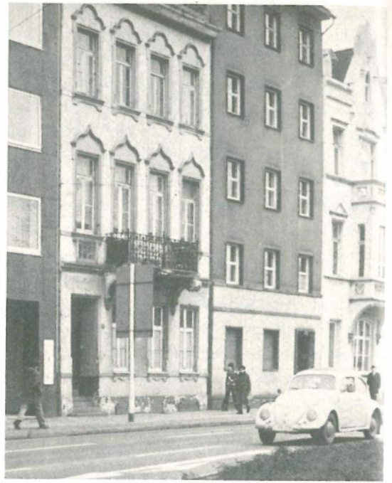
Haus Haroldstraße 18 (abgerissen 1973)
