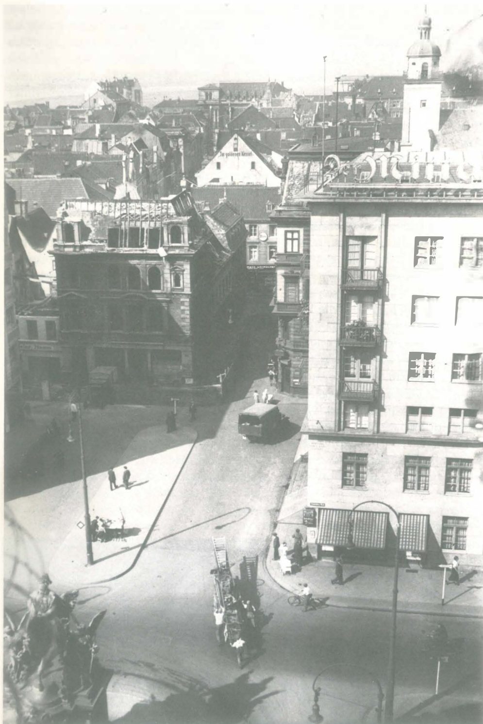
Abbruch der Häuser an der Kommunikationsstraße für den Durchbruch der Bolkerstraße
