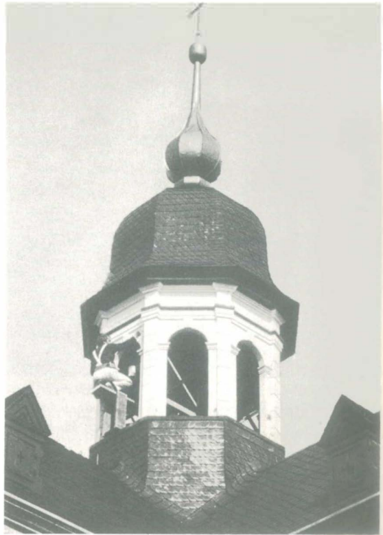
Instandsetzung des Daches und Neuanstrich der Laterne - Dachgauben vor der Erneuerung Foto: E. Spohr
