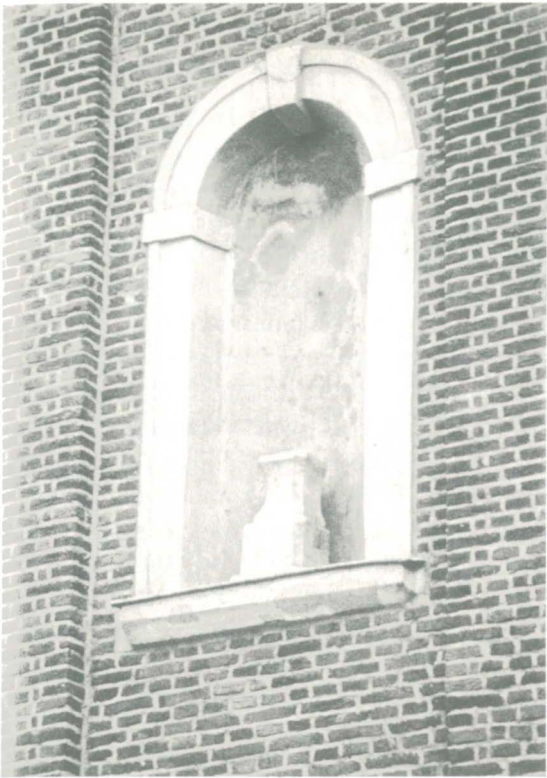
Backsteinmauerwerk nach Ausbesserung - Nischen während der Restaurierung vor Aufstellen der neu modellierten Figuren Foto: E. Spohr
