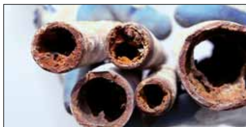
Wenn Kalkablagerungen und Rost die Rohre fest im "Griff" haben, kann die Wasser-Luft-Spülung hier helfen.
