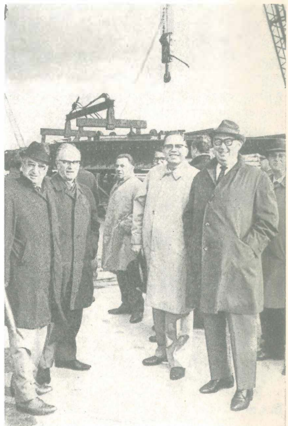
Die Jonges folgten einer Einladung ihres Vorstandsmit-gliedes Graf von Roedern und besichtigten Düsseldorfs größte Baustelle, die Kniebrücke in Oberkassel (Foto Karl Schlüpner)
